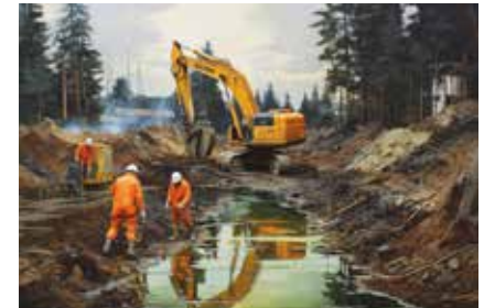
▶ 도로 / 관로 / 토목 공사 현장
